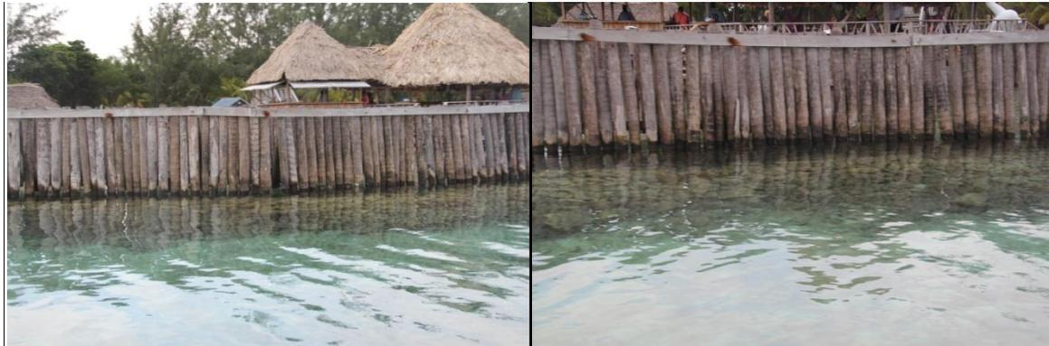
Imagen 15- Muro de contención formado por troncos de madera con protección de rocas en la base (Cocoplum Caye). Fuente: Propia
