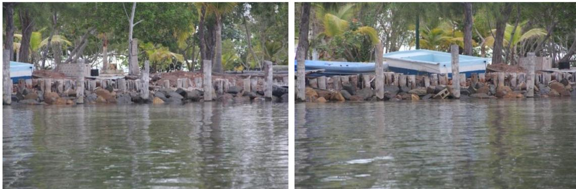
Imagen 16- Muro de contención formado por troncos de madera con protección de rocas en el frente (Thatch Caye). Fuente: Propia
