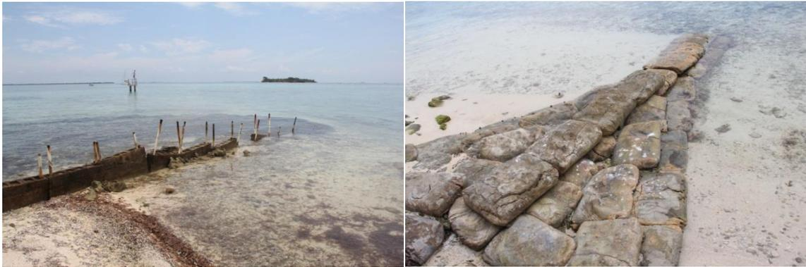
Imagen 20- Espigones creados con ladrillos y sacos de cemento (Carrie Bow Caye). Fuente: Propia
