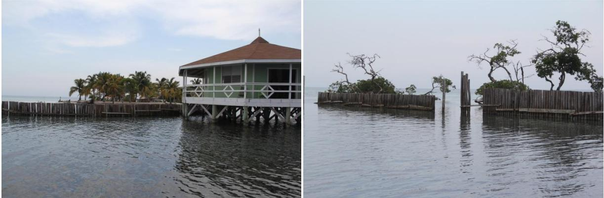
Imagen 11- Muro de contención formado por troncos de madera (Ragga Caye). Fuente: Propia
