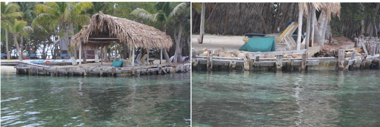
Imagen 14- Muro de contención formado por troncos de madera con protección de la línea de costa con rocas en la parte protegida (Cocoplum Caye). Fuente: Propia
