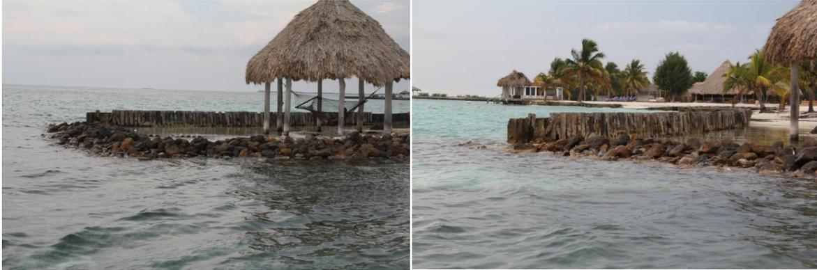
Imagen 9- Muro vertical con troncos de madera (Ragged Caye). Fuente: Propia
